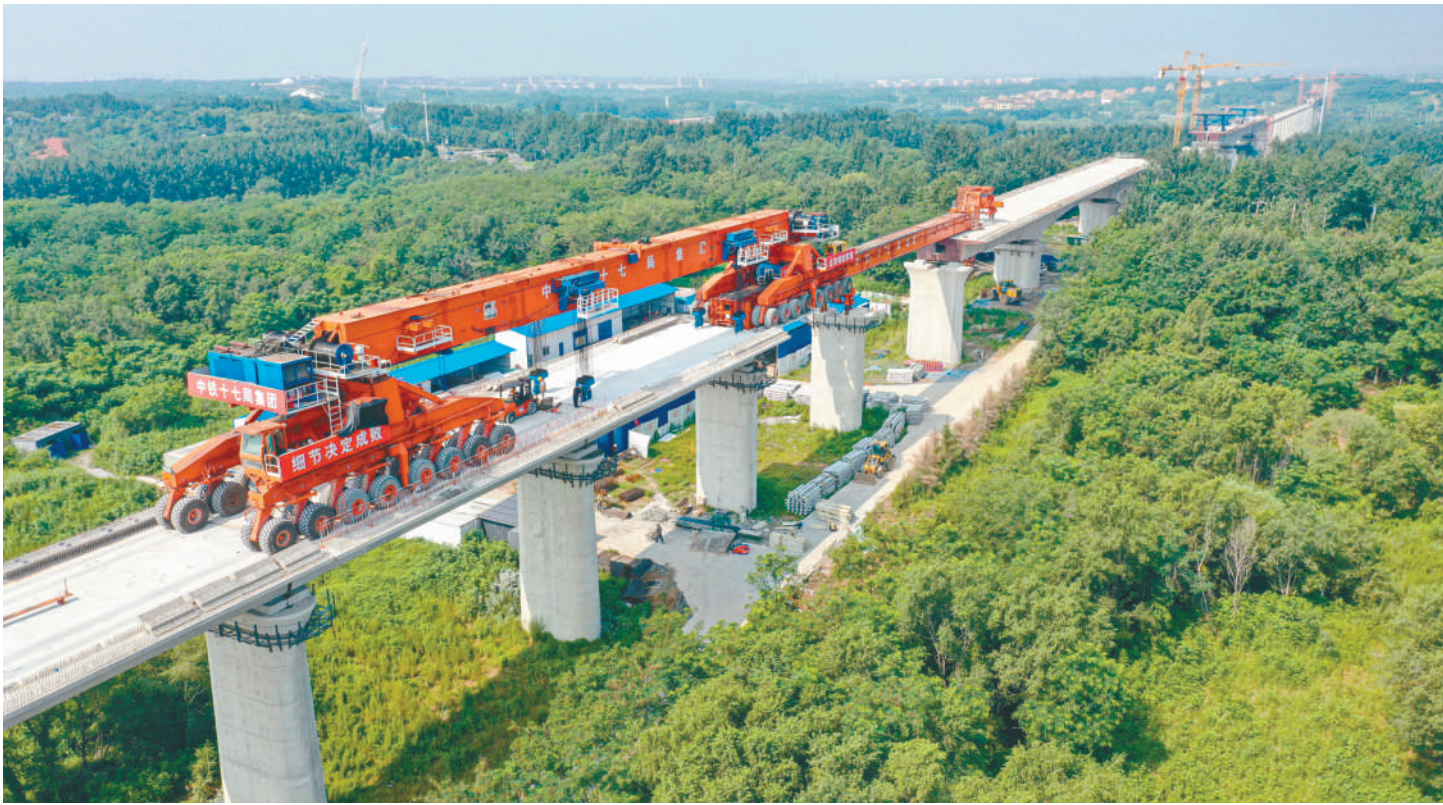
7月18日,沈白高铁满堂特大桥施工现场,连续梁空中作业忙。据了解,沈白高铁是国家中长期铁路网东北东部快速铁路通道的重要组成部分,正线全长430.1公里,设计时速350公里。 张文魁摄
